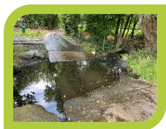
Traversée cours d'eau
